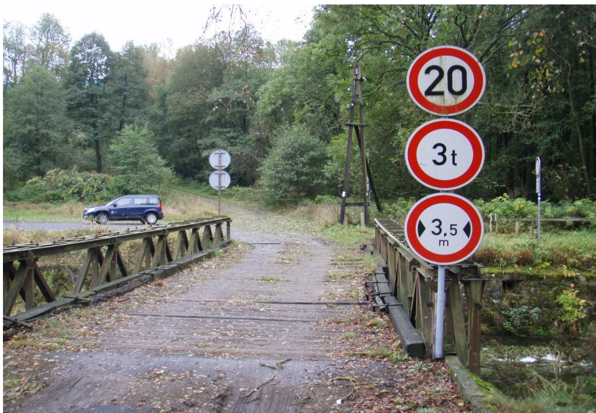
Příloha č. 1 – Přístup přes most v havarijním stavu
