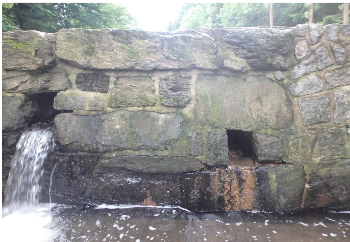
Příloha č. 7 – Poškozené spárování – oprava spárování
