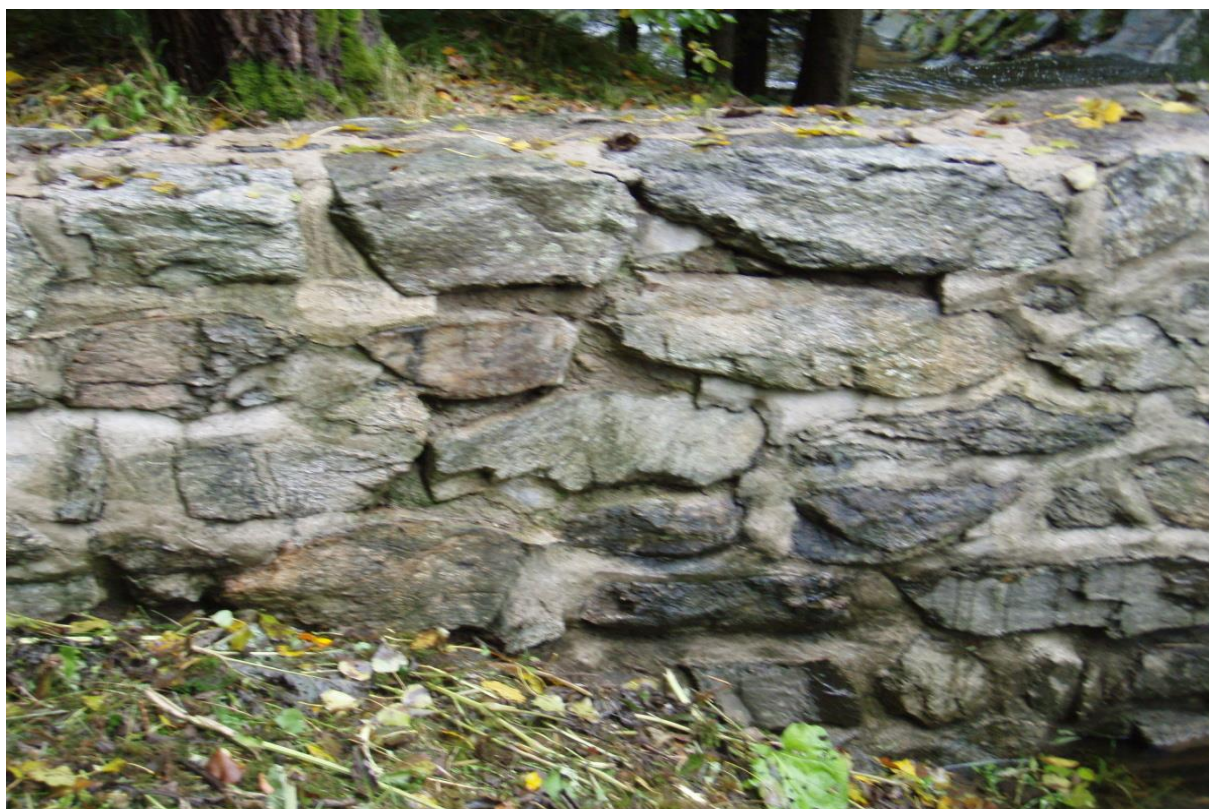
Příloha č. 8 – Poškozené spárování – oprava spárování
